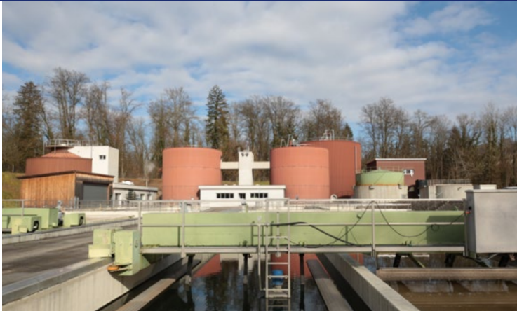
Becken mit Räumern und Schlammstapel im Hintergrund
