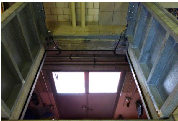
Das Bodentor bei der Schlammentwässerungsanlage wurde zur Erhöhung der Arbeitssicherheit mit einer hydraulischen Öffnung nachgerüstet.
